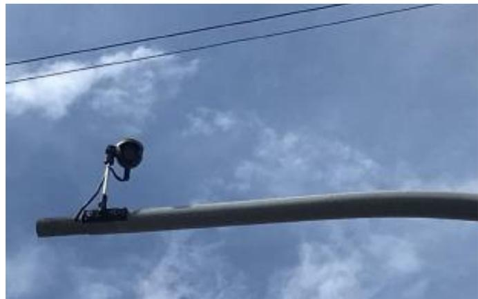
2. Cámaras de detección de vehículos que funcionan como sensores no intrusivos y que permiten gestionar los tiempos de verde de manera automática de acuerdo a la longitud de cola de la vía secundaria.
