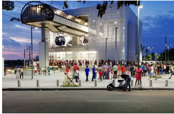
Ilustración 21 –Estación de Integración del teleférico con el metro (Eduardo Brito)
