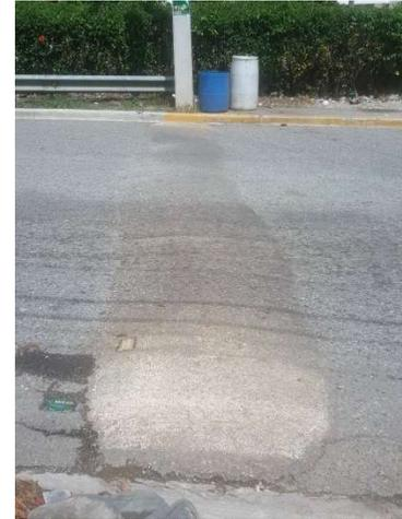
En la Carretera Federico Basilis (Sección de Bayacanes, La Vega) la señalización horizontal de los reductores de velocidad tipo Lomo, es muy deficiente, la pintura está totalmente desgastada; mientras que en el Distrito Municipal de Buena Vista, Jarabacoa, la señalización de los reductores está en buenas condiciones, aunque están pintados con rayas blancas y amarillas de manera transversal, como se muestra en las fotografías.
