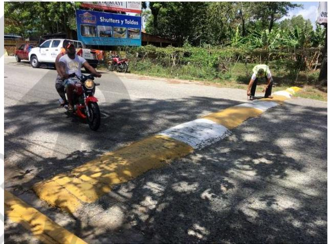
El ancho de los reductores de velocidad Tipo Lomo de Asfalto varía desde 0,60 mt hasta 3,30 mts.
