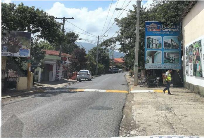
En estas imágenes se pueden observar los reductores de velocidad que se extienden hasta la acera y el paseo, para evitar que los conductores desaprensivos e imprudentes lo evadan.
