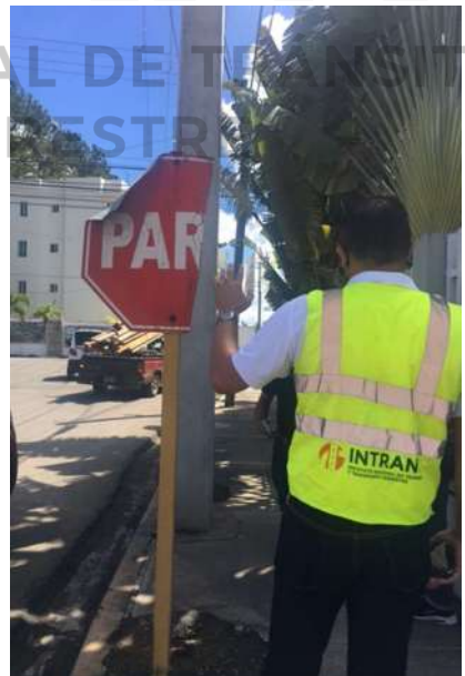
Señal de Pare colocada a una altura incorrecta, representando un peligro para los peatones
