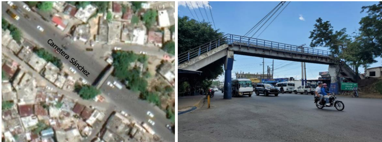
Ilustración 29: Carretera Sánchez – Puente Peatonal
