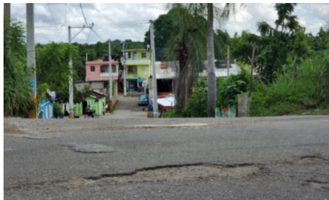
Ilustración 17: Baches en la calzada
