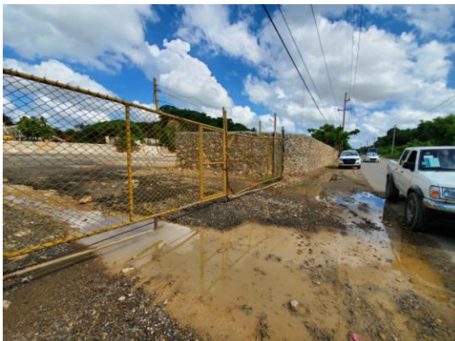
Ilustración 11: Acumulación de agua en la entrada y salida de camiones de TDC
