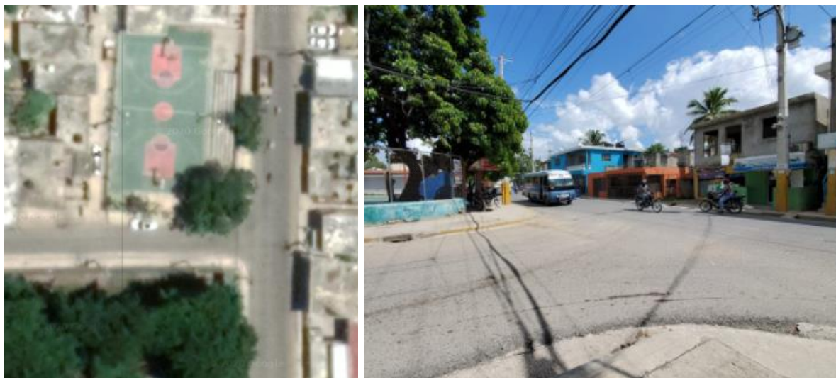
Ilustración 23: Carretera Quita Sueño – Calle 2da
