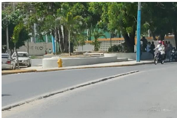
Ilustración 4: Restos de muro divisorio de sentido de circulación Av. Laureano Canto
