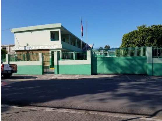
Centro educativo sin reductores de velocidad ni señalización.
